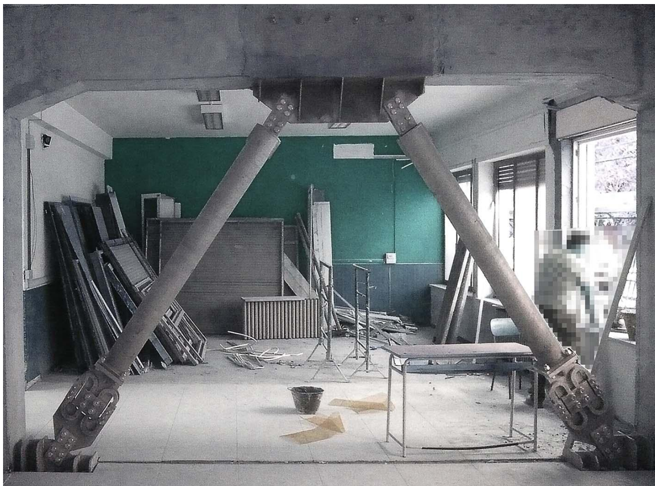
Installazione di controventi dissipativi
