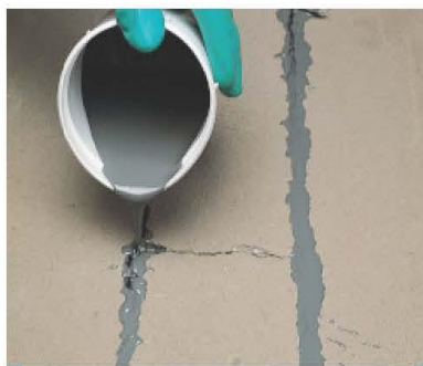
Riparazione crepa di massetto cementizio con Eporip
