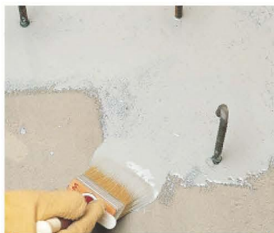
Applicazione di Eporip a pennello per ripresa di getto
