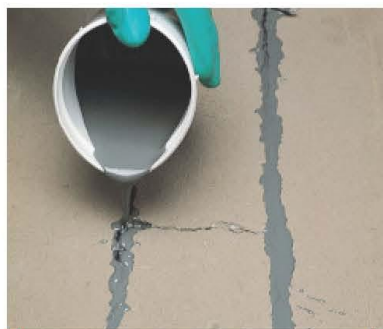
Riparazione crepa di massetto cementizio con Eporip
