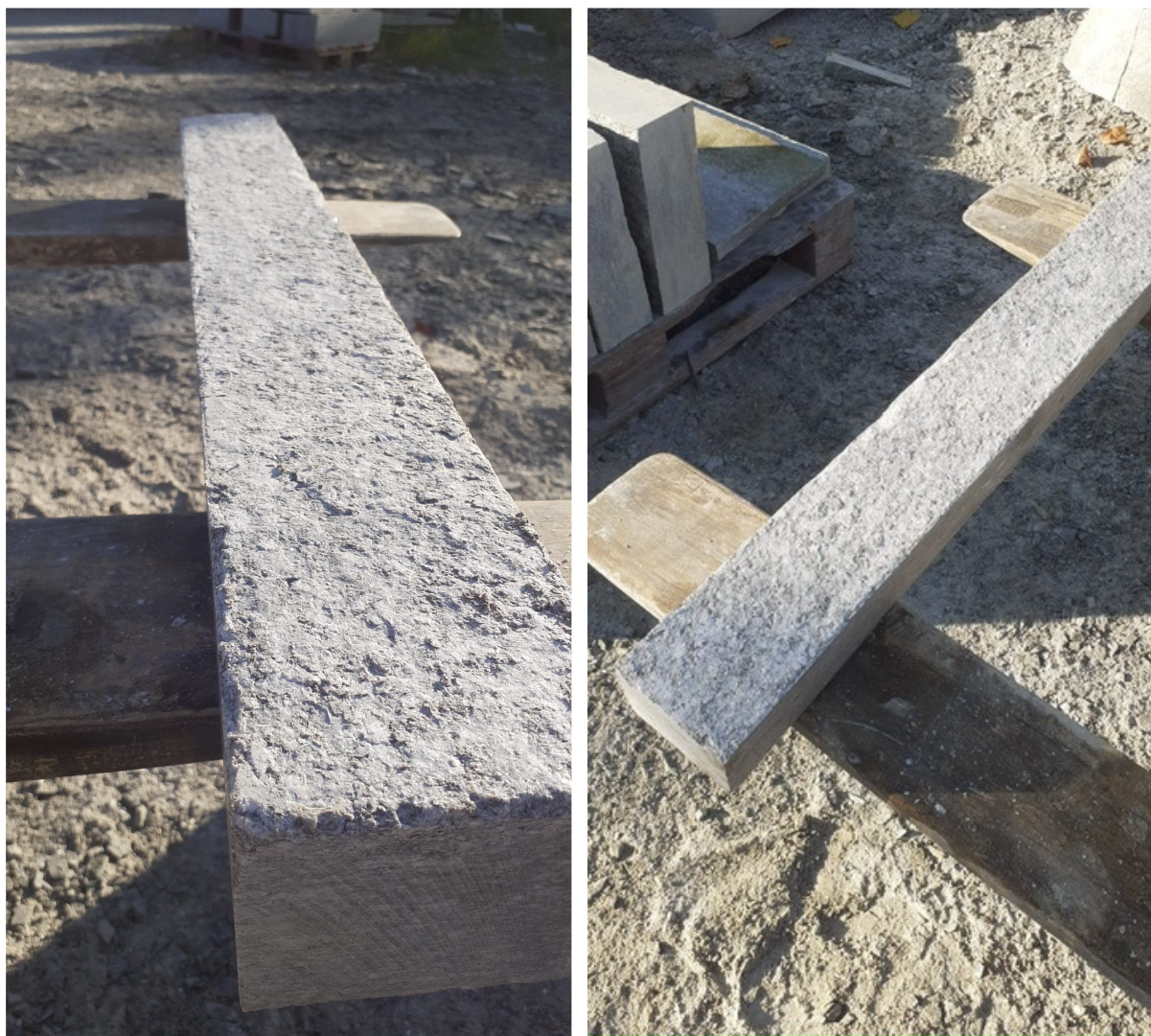
Vista esemplificativa di elemento di pavimentazione coste segate finitura fiammata
