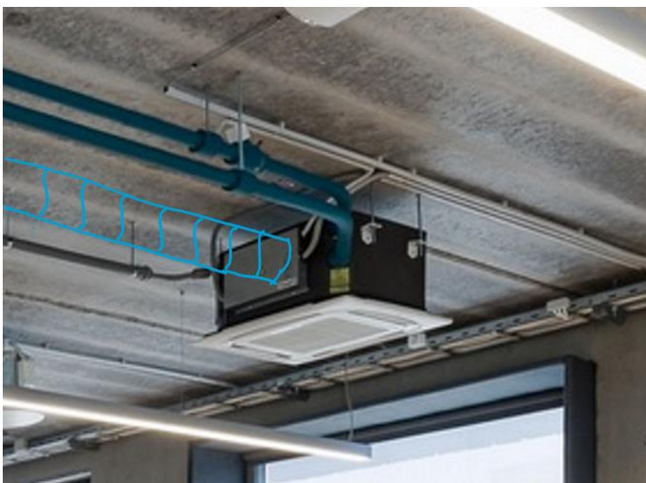
Figura 4 - Cassetta a 4 vie a soffitto a vista con alimentazioni fluidiche e aria a vista
